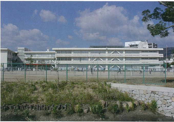
加里屋川側から見た赤穂小学校の耐震化の状況
