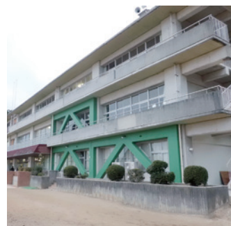
耐震補強が完了した赤穂西中学校
