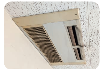
トラストホープ球場本部室
