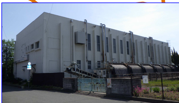
【御崎ポンプ場】
