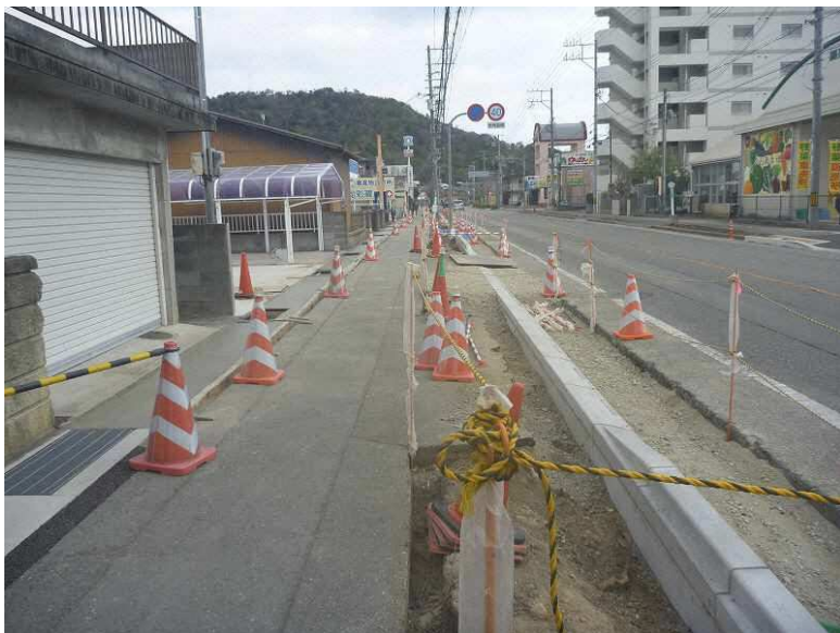
道路北側歩道の施工状況
