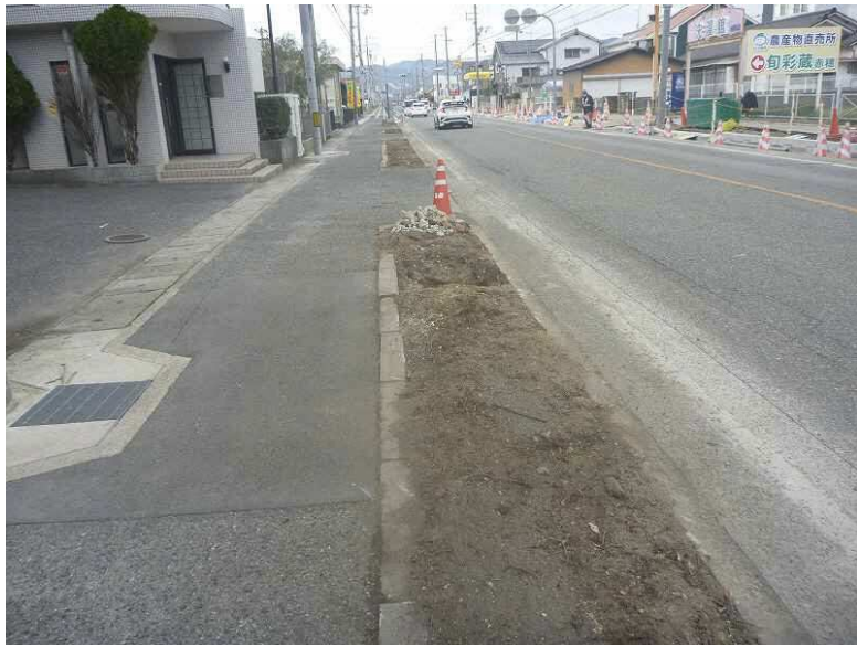
道路南側歩道の状況 (植樹帯の撤去)
