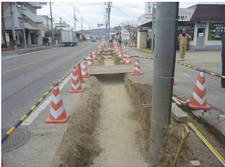
道路北側歩道の植栽撤去状況 (出入口部の鉄板養生)
