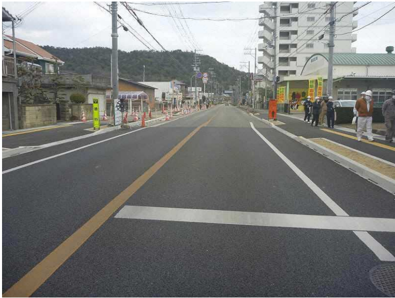
起点側より工事区間の全景
