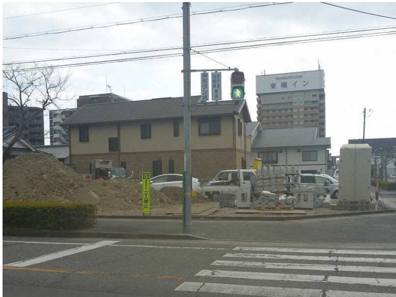
道路南側仮設ヤード全景 (資機材、残土仮置き)
