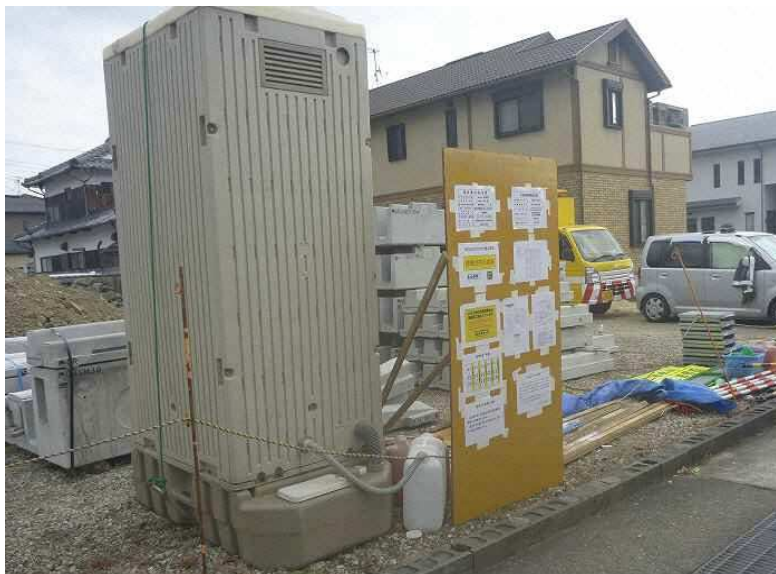
安全衛生看板の掲示状況 (仮設ヤード前)
