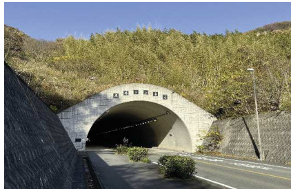
【尾崎トンネル】
