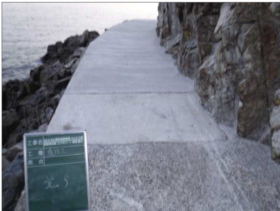
写真区分: 御崎遊歩道コンクリート舗装 工種: 完成 タイトル: 完成
