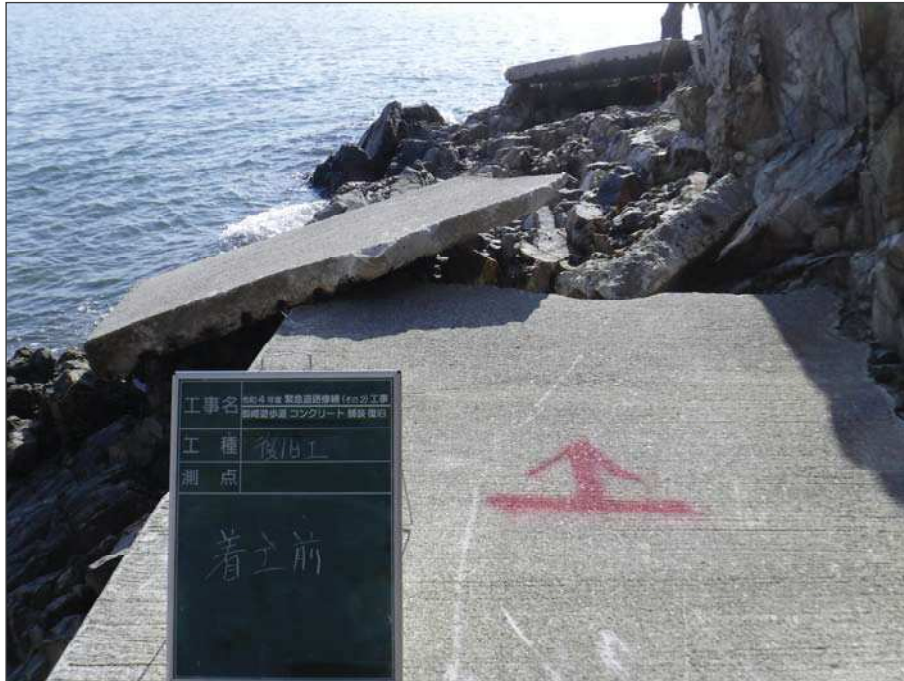
写真区分: 御崎遊歩道コンクリート舗装 工種: 着工前 タイトル: 着工前
