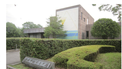
浜田中継ポンプ場
