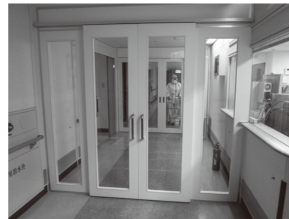
コロナ病床のある区画はウイルスの漏出を防ぐため、二重扉が設置されています。
