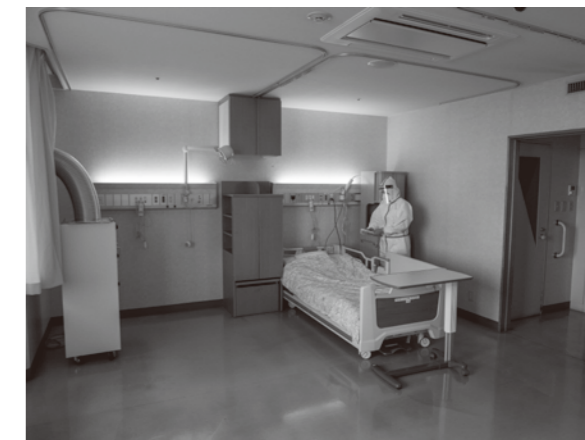
病室内は陰圧装置により常に陰圧に保たれ、病室の空気が外部へ漏出するのを防ぎます。
