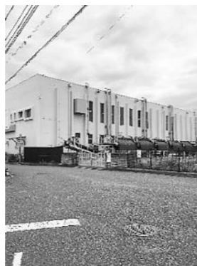
御崎ポンプ場
