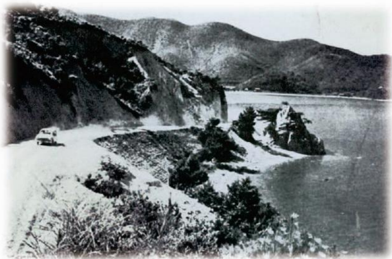
1960年(昭和35年)ごろの壺根坂越線(潮見東付近)
